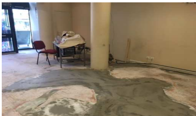
L'ajustement du fond avec une chape de béton
